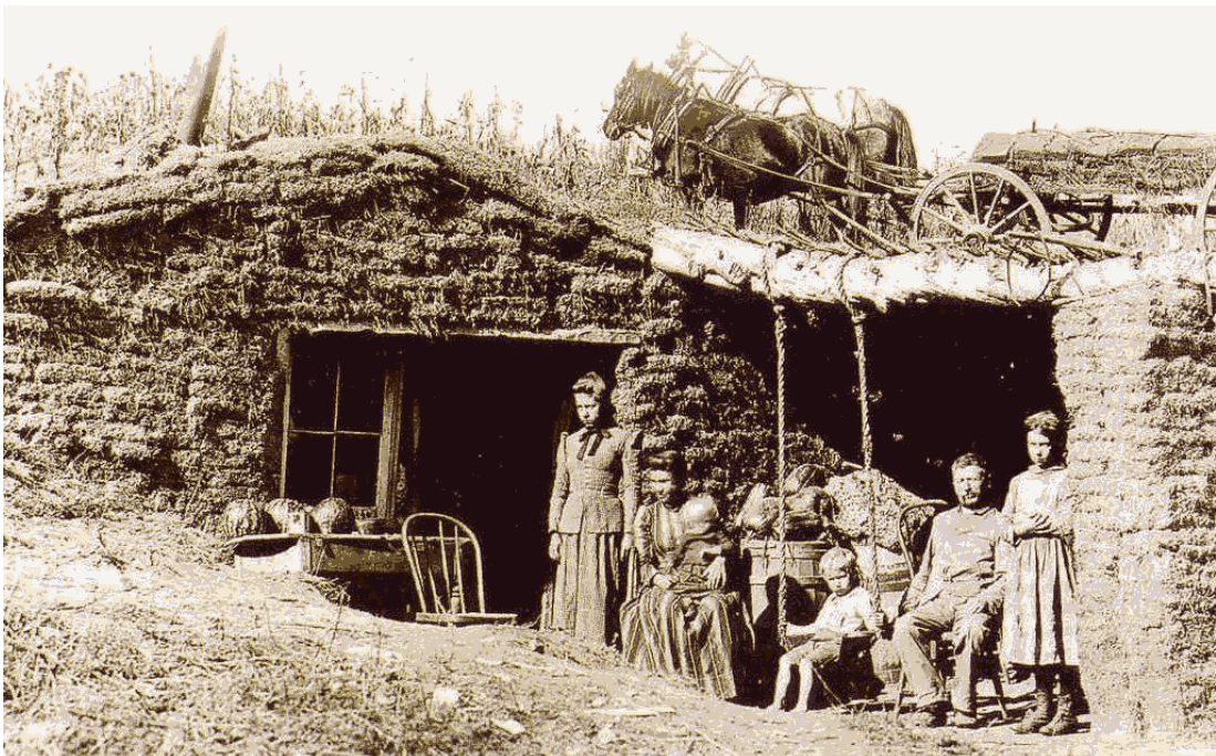
Ein in die Erde eingegrabenes Haus aus Grassoden in Nebraska um 1890
