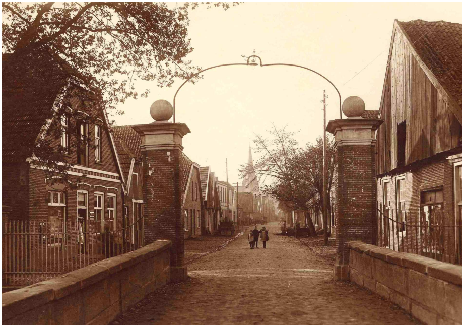
Neuenhaus, Hauptstraße, vom Stadtteil Teich aus gesehen, Anfang der 30er Jahre. Das Foto zeigt noch die alte „Diek-Poarte“ aus Bentheimer Sandstein, welche 1939 abgetragen wurde, um Platz für eine Straßenverbreiterung zu schaffen.
