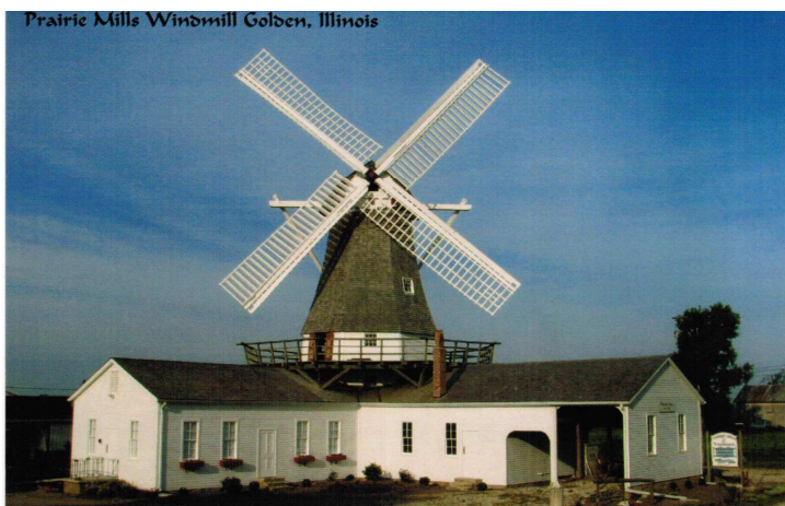
6. Die restaurierte Windmühle in Golden (Illinois)
